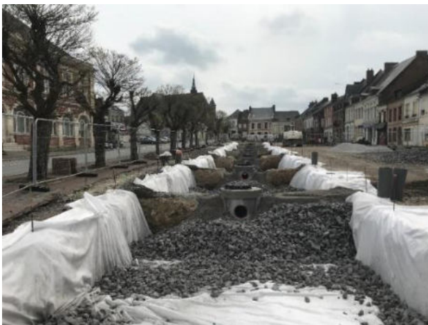
Figure 4 : Chaussée à structure réservoir en cascade à Montcornet (08) (©Ingessia) et parking de 20 000 m 2 en structure réservoir cloisonnée, alimentée par des noues d'infiltration à Yutz (©AERM)
