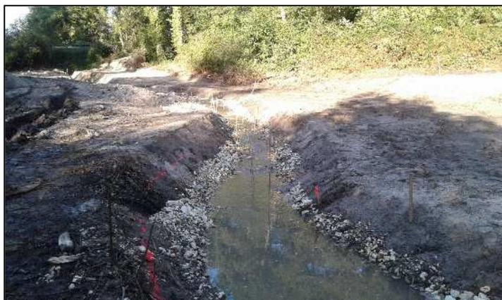
La première phase des travaux de restauration du lit de l'Altrée (affluent du Couasnon) a débuté fin juillet 2021. L'objectif est de remodeler le cours d'eau, autrefois rectifié et recalibré, afin de favoriser la recharge de la nappe alluviale. Le reméandrage du lit a également permis de reconnecter l'Altrée à des bras morts ou zones humides. Les travaux se poursuivront à l'été 2022 pour permettre au ruisseau de s'écouler librement dans la tourbière de Grésillon dès la fin de l'année.
