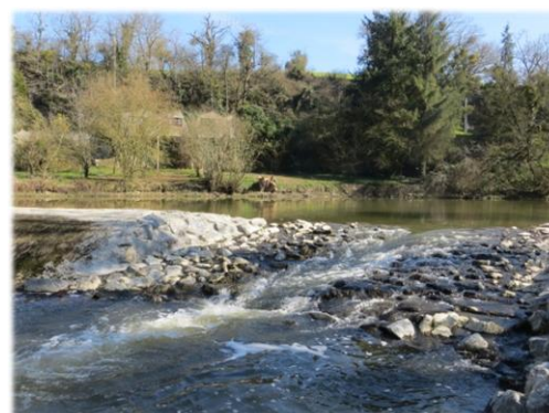
L'Èvre à Beaupréau Aménagement de chaussée du Moulin de Moine (photo SMIB)
