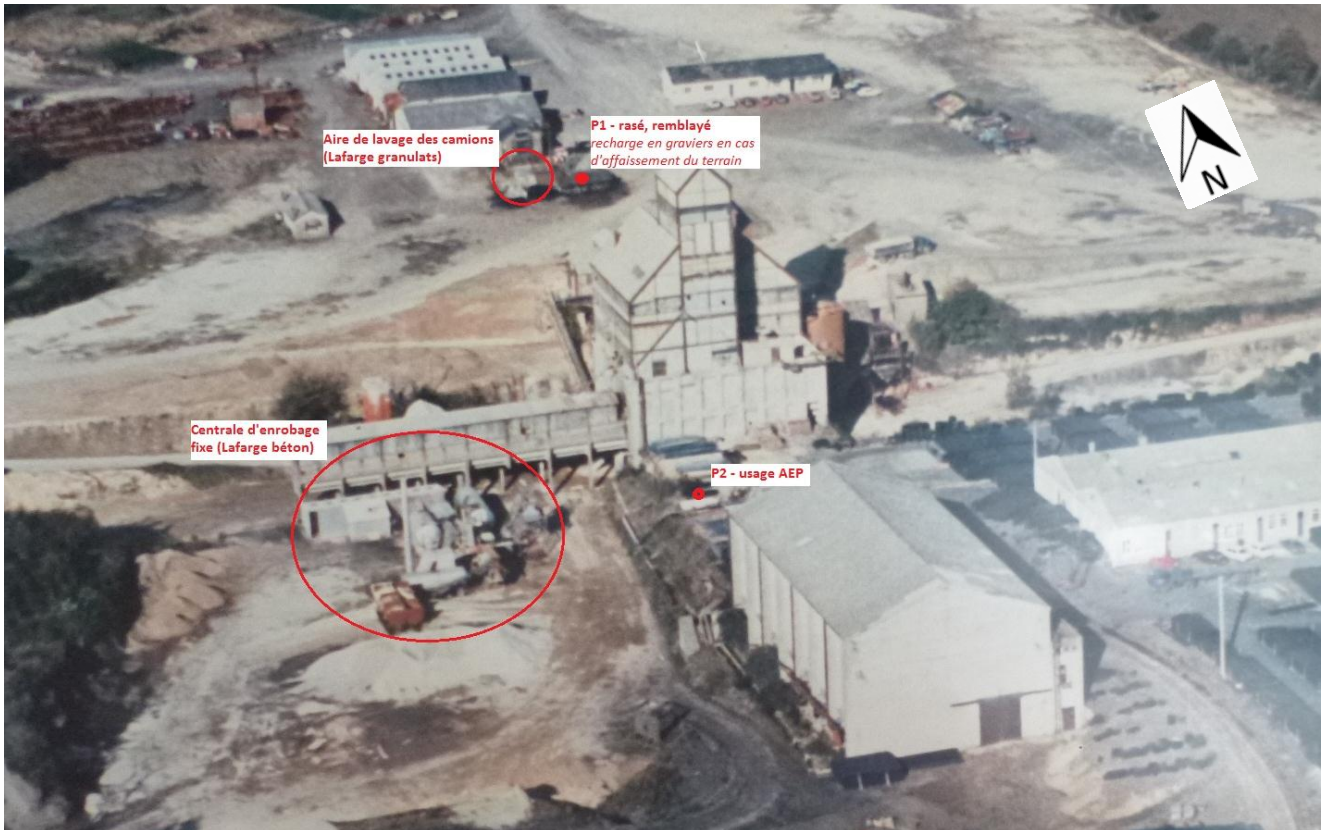
Illustration 2 - Vue d'ensemble du site Lafarge et position du captage de Chazé-Henry (Source photo : Lafarge granulats)
