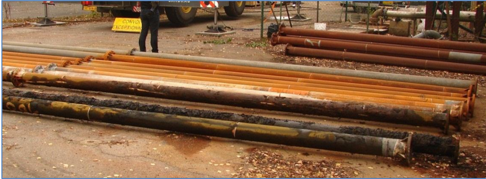
Illustration 17 - Barres de canalisation présentant un dépôt noirâtre et une forte corrosion (Chazé-Henry Mine de fer, décembre 2013)
