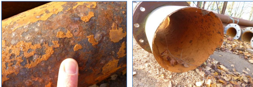
Illustration 18 - Détail de la corrosion affectant les canalisations (Chazé-Henry Mine de fer, décembre 2013)
