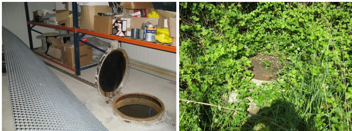
Illustration 26 – Le Louroux-Béconnais, photo de l'ouvrage 04246X0002 à gauche et du deuxième piézomètre de contrôle à droite (BRGM, 2015)
