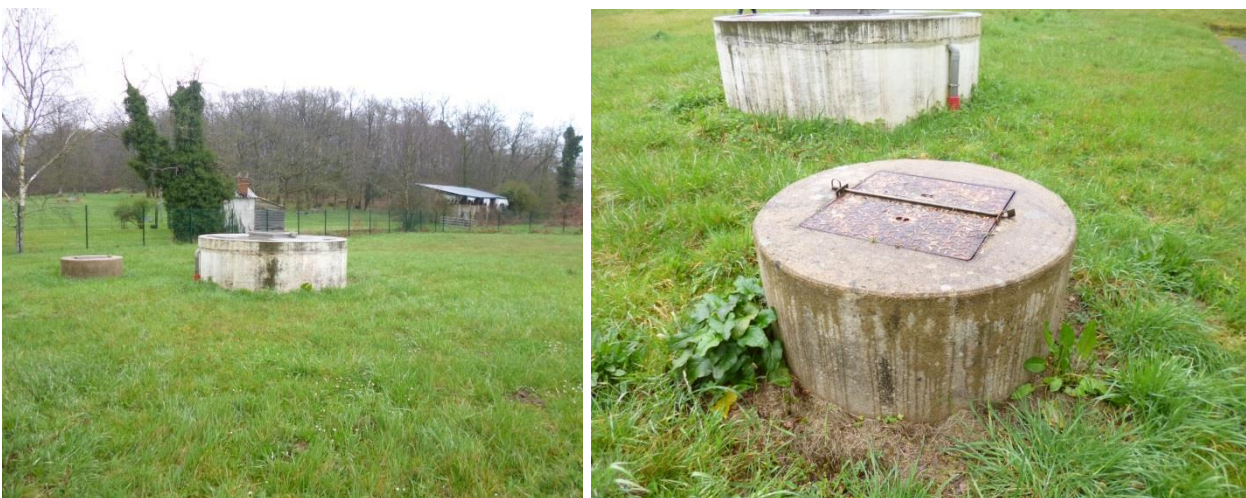
Illustration 32 - Mouliherne, photos des ouvrages 04561X0017/F et S1 (BRGM, 2015)
