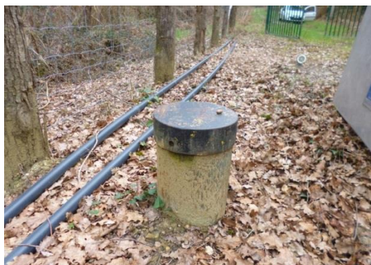
Illustration 45 - Vernantes – bois de Buton, photo du piézomètre (BRGM, 2015)
